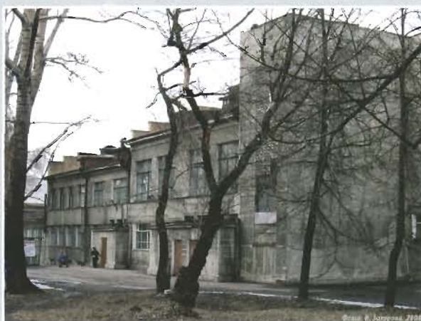
▲ Вид здания ДК до ремонта
